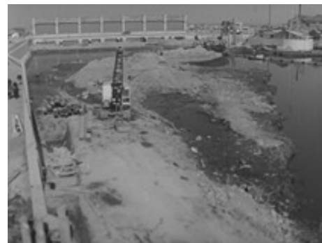
今井水門付近の工事の様子
